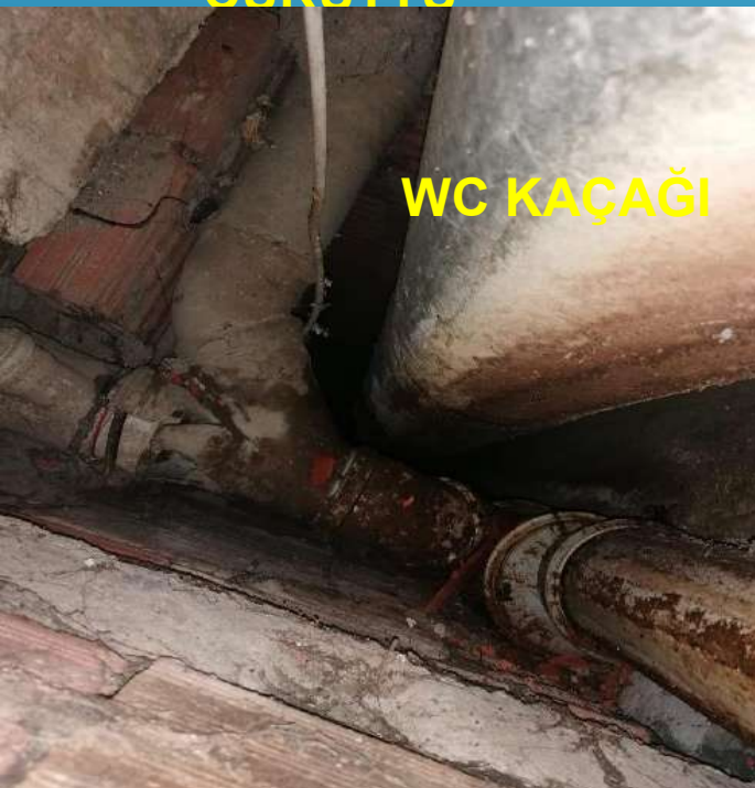
WC KAÇAKLARI ŞAFT İÇİNDE DUVAR VE BACAYI CÜRÜTTÜ
